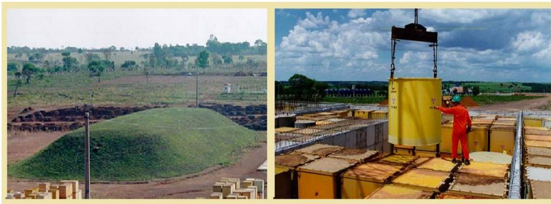
**Figura 2.1** - Depósito 1 (à esquerda) de grande porte e Depósito 2 (à direita) para rejeitos de baixa e média atividade
