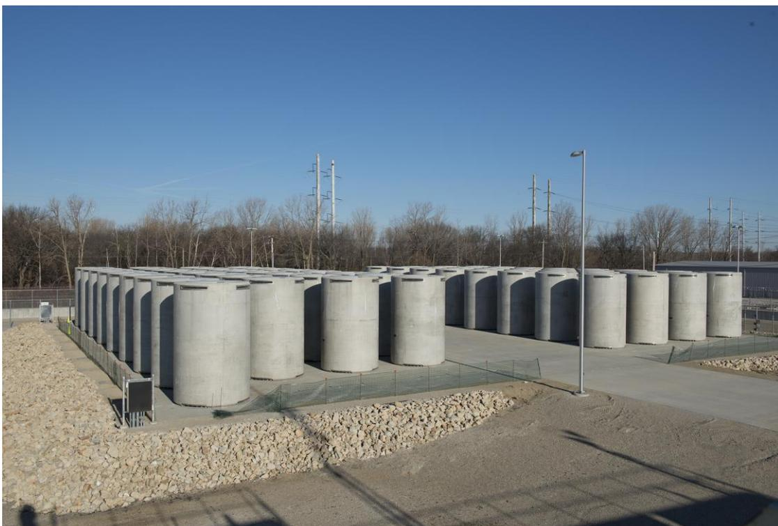
**Figura 5 - Dry-casks para armazenamento de combustível irradiado (ZionSolutions, 2015)**
