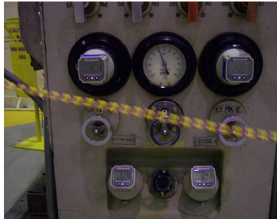
Figura 60 - Leitores de Medidores Sem Fio Honeywell (Wireless Gauge Readers) instalados em medidores na Central Nuclear Vermont Yankee. (Honeywell 2010)
